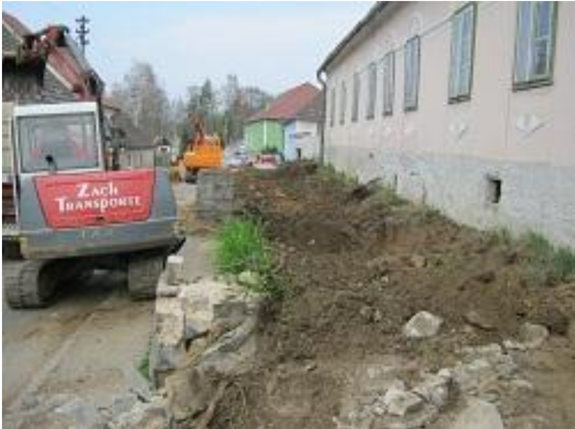
Abriss der Stützmauer vor dem Haus Niederedlitz 48
